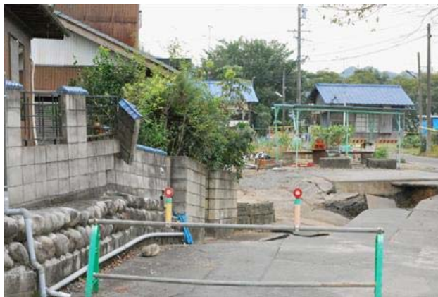
Photo4. 岐阜県御嵩町の陥没事故現場
